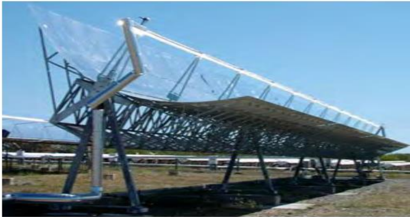
شکل ۲- نیروگاه سهموی خطی ۲۵۰ کیلووات شیراز (منبع مورد استفاده: انرژی خورشیدی) [۳]
